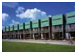
Wohnanlage, Purmerend, NL Roy Gelders Architecten, Amsterdam Ridder Dak- en Wandsystemen BV, Hoorn TECU® Patina
