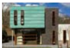
Privathaus, NL Charles Slot Bureau Ruimtelijke Vormgeving, Bergen PBK Technische Installaties BV, Alkmaar TECU® Patina
