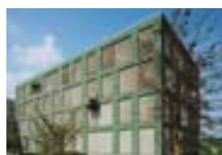
InnovationsCampus der Wolfsburg AG, Wolfsburg O.M. Architekten BDA, Braunschweig Bisping GmbH & Co., Münster TECU® Net Patina
