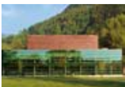
Produktions- und Bürogebäude Elektro Graf, Dornbirn, A Baumschlager & Eberle, Lochau Güther GmbH, Feuchtswangen, D TECU® Oxid
