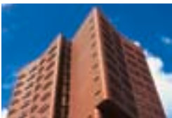
Offiziersquartier der Königlichen Marine der Niederlande, Den Helder, NL Van Herk & de Kleijn Architecten BV, Amsterdam Ridder BV, Hoorn TECU® Classic
