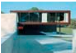
Roche Forum, Buonas, CH Scheitlin + Syfrig, Luzern Gebr. Baur AG, Baar TECU® Oxid
