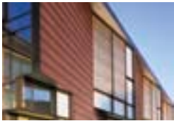
Produktions- und Bürogebäude, Baar, CH Burkart, Bauabteilung Baar; Barkow Leibinger Architekten, Berlin Gebr. Baur AG, Baar TECU® Oxid
