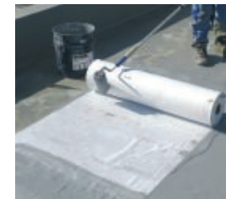
3. Das KEMPEROL® Vlies wird eingelegt und mit einem Perlonroller angedrückt
